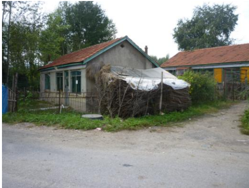
安口镇转运站西侧
