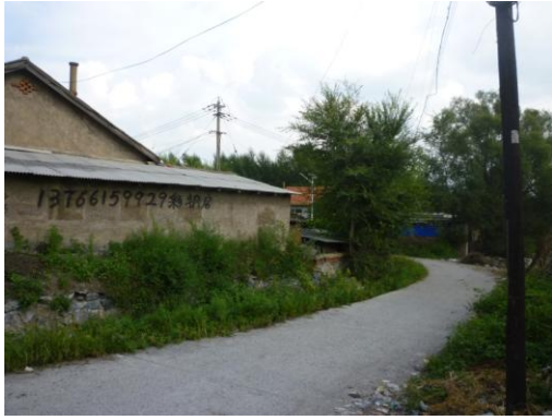
安口镇转运站东侧
