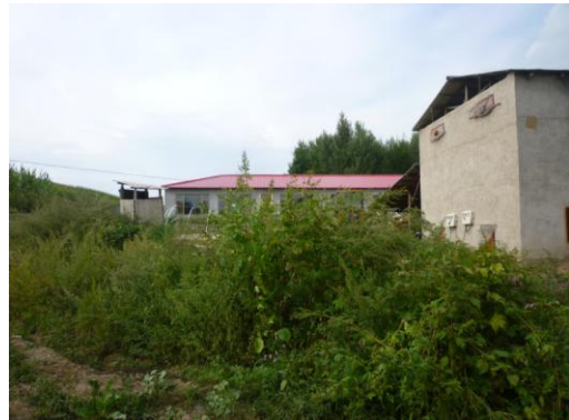
一号转运站北侧
