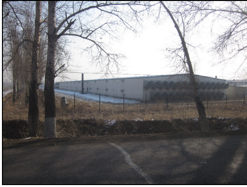
图 2-7 变电站东南侧边岗种粮场（鸡舍）
