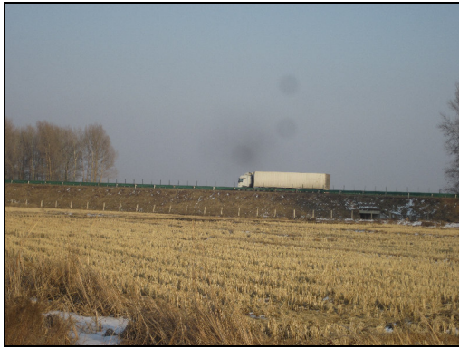
图 2-35 跨越京哈高速公路
