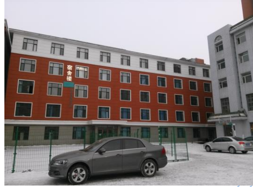
拟拆建筑旁的宿舍
