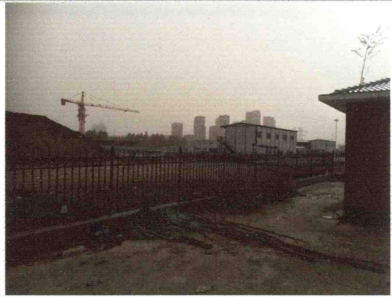
珠海路开闭所南侧施工场地
