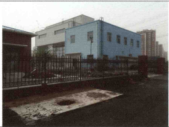
珠海路开闭所北侧 220kv 变电站
