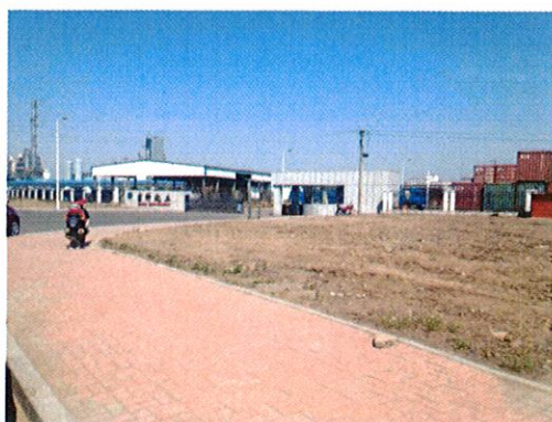
厂区西北侧吉神化工
