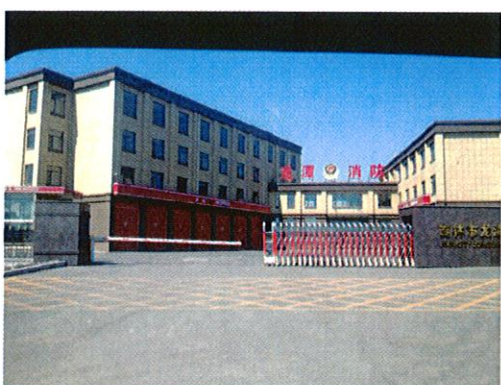
厂区南侧消防站
