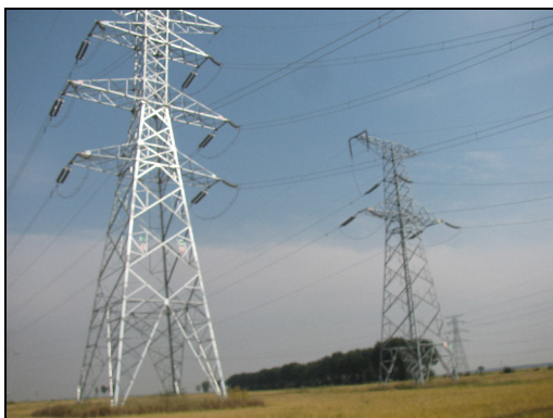
图片 2 乔嘉变电站出线处
