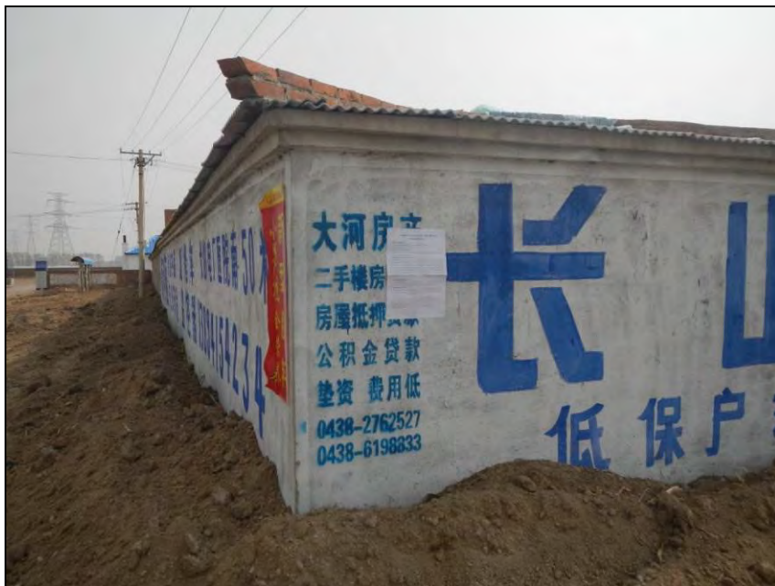
第一次现场公示
