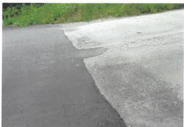
拟建项目起点处
