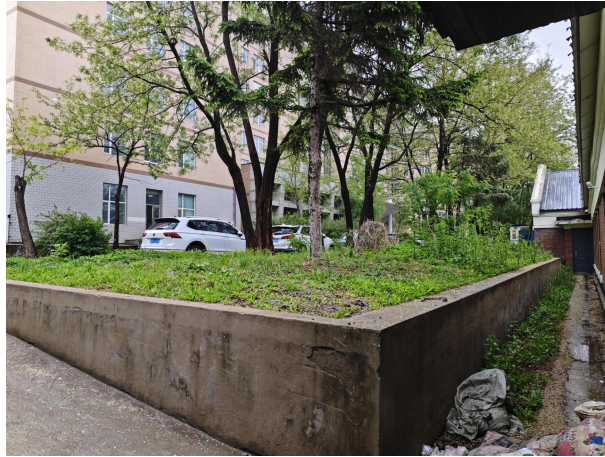
拟建工业 CT 实验室东侧室外
