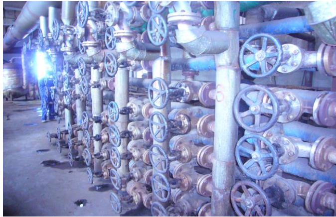
图 5-2 多组串联方式水解操作台
