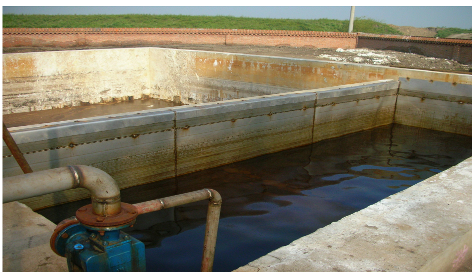
图 4-3 材质为白钢的工艺废水收集池
