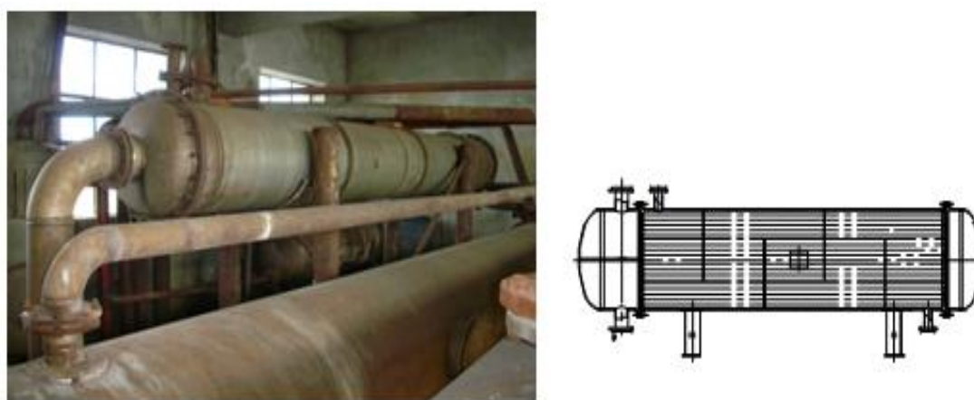
图 4-2 桶式全封闭冷凝器
