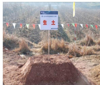
同类工程生土、熟土分开堆放
