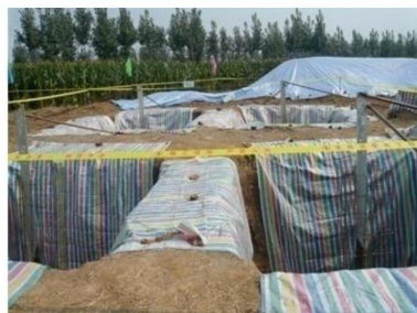
临时堆土苫盖
