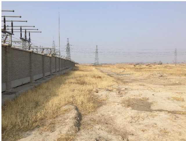
图 2.3-2 乾安 220kV 变电站本期扩建区域概况
