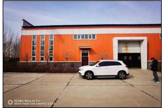
探伤室所在厂房南侧
