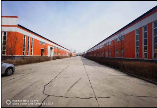
探伤室所在厂房东侧
