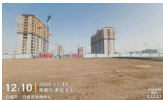
图1 东侧在建锦唐小区（拟建场地）
