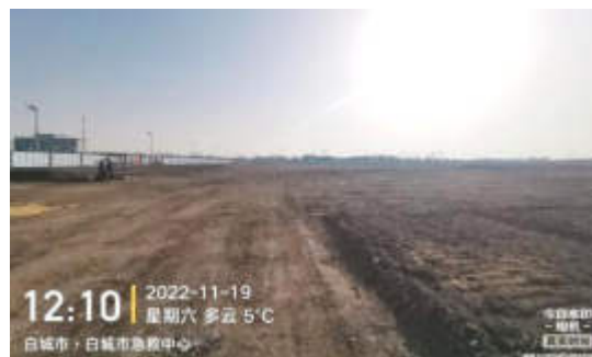
图2 新建院区南侧（拟建场地）
