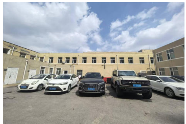
(7) 北侧影像综合楼
