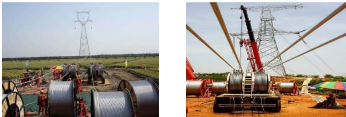
图 3.1-4 线路工程沿线牵张场布置形式照片
