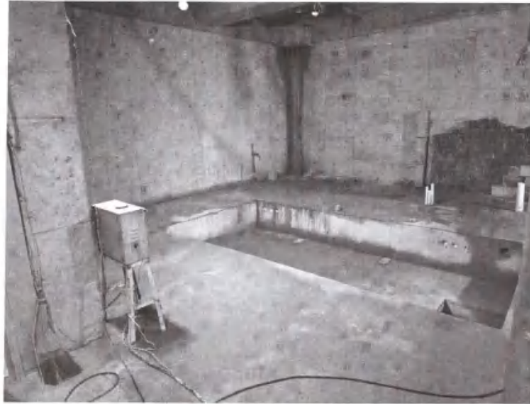
附图 4 长春肿瘤医院新建地下停车场工程地下二层项目拟建区域
