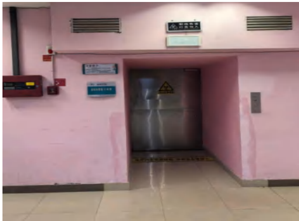
(1) 放疗科加速器机房入口 (-2F)
